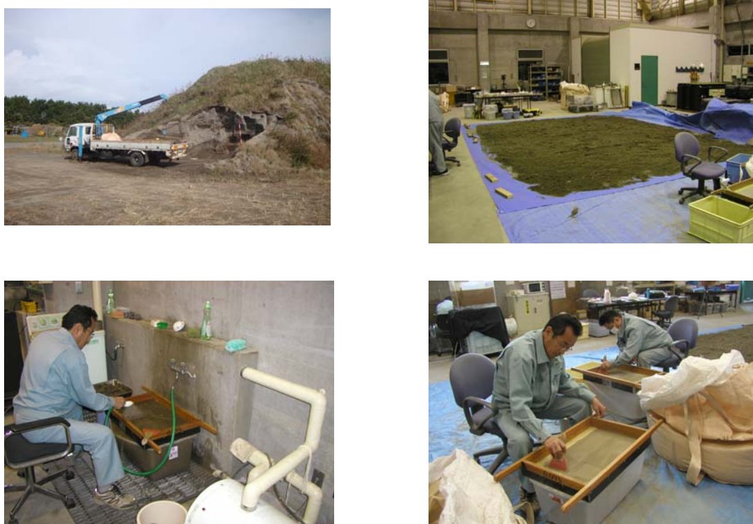
図 3.1-1 東日本大震災時に浦安市で発生した填砂の試料採取と粒度調整状況
