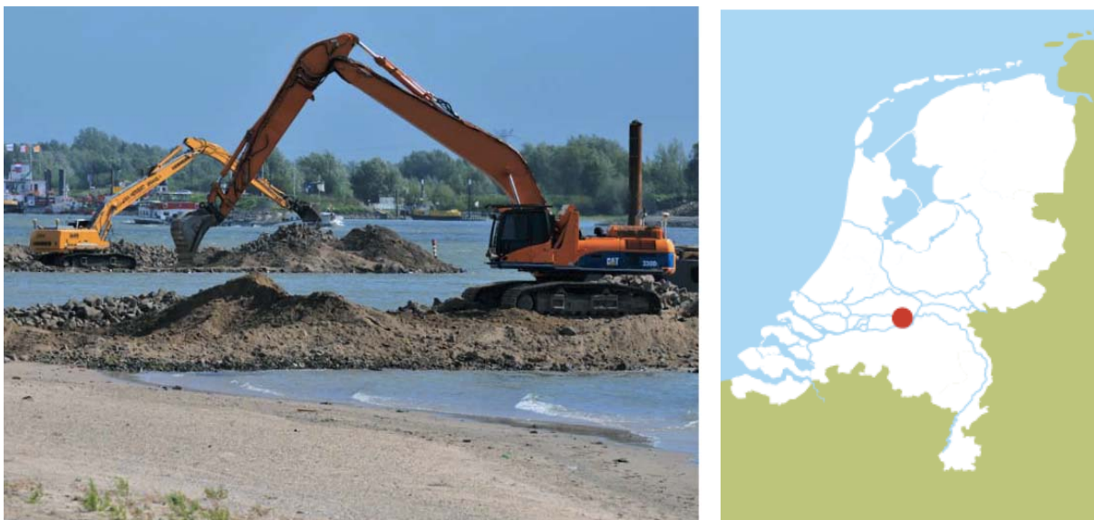
図 3-23 ワール川水制工切下げ事業の施工状況と事業実地位置図
