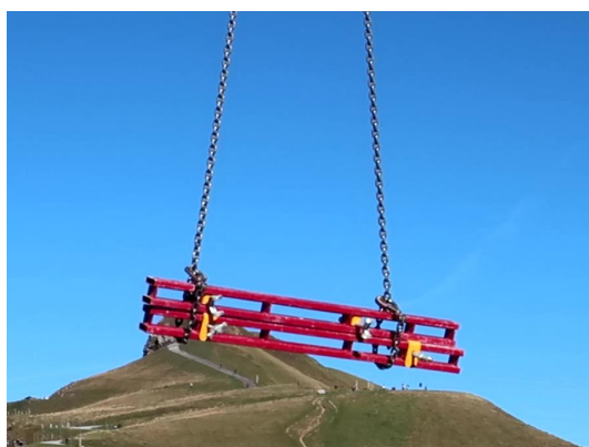
(a) システム型枠連結材の運搬
