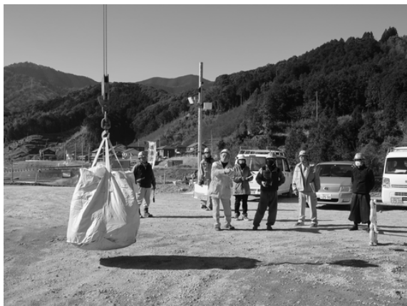
写真-7 大型土のう袋による操作リハーサル
