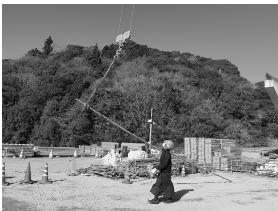
写真-8 連結した単管による操作リハーサル
