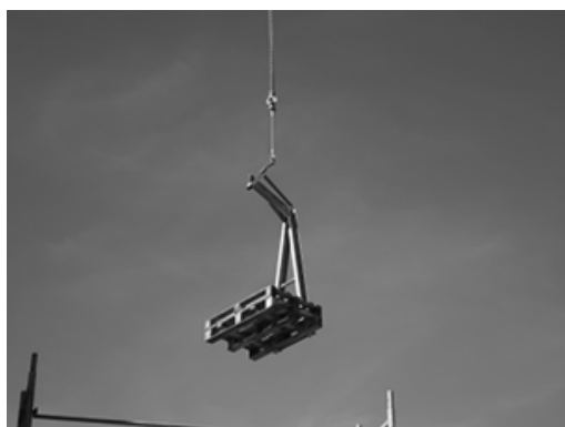
写真-6 資材運搬に使用するパレットハンガー
