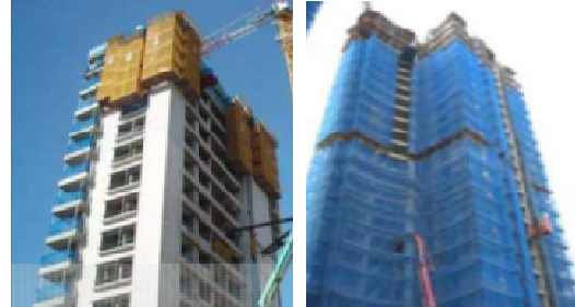
図-1 自動昇降式足場(左)と従来型の外部足場(右) 9)
