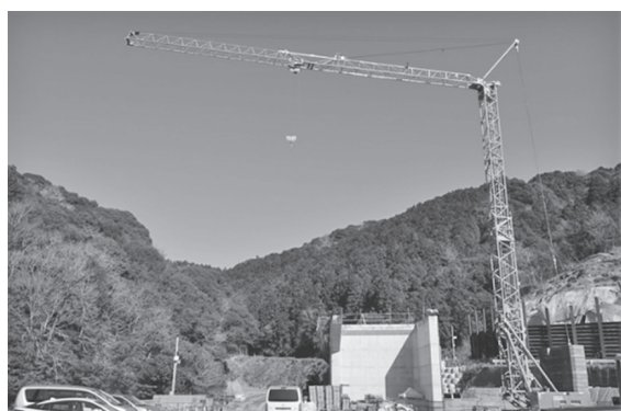
写真一 定置式水平ジブクレーン
