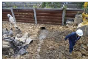
工事に伴う埋設物の損傷事故
