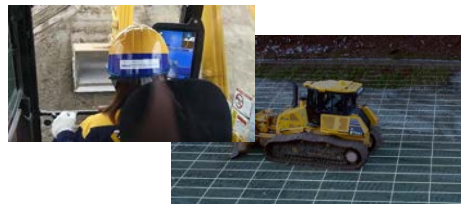
ICT建機による施工
