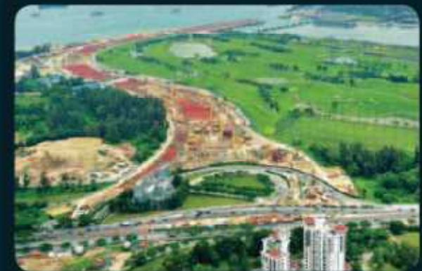
ECP/KPE Interchange (C487) Excavation and strutting work at ECP/KPE Interchange 在东海岸公园大道和巴耶利巴快速公路交界处展开挖掘与支撑的工作
