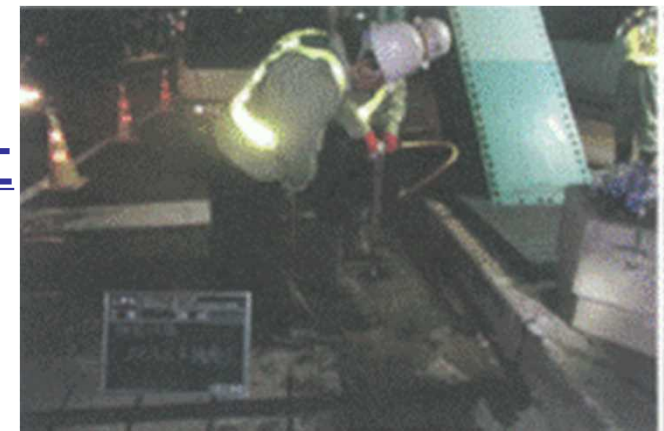
試掘による舗装の健全度調査
