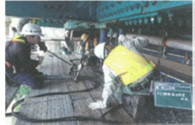
足場を用いた健全度調査
