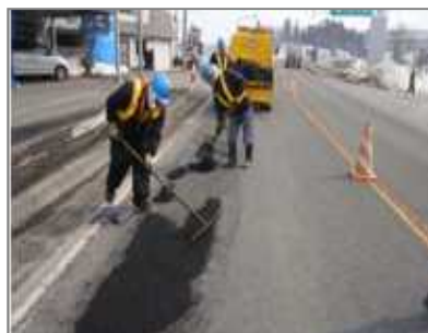
舗装版舗設作業
