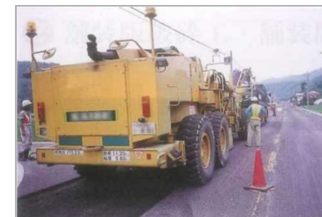
路面切削作業
