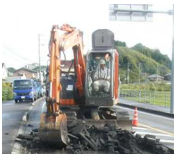
舗装版破碎作業
