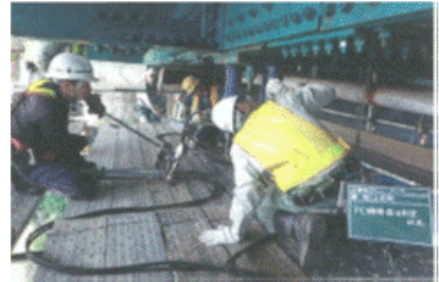
足場を用いた健全度調査
