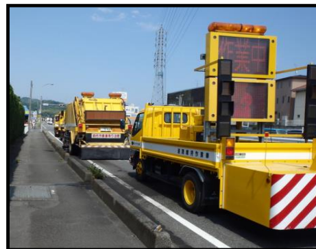
路面清掃作業状況
