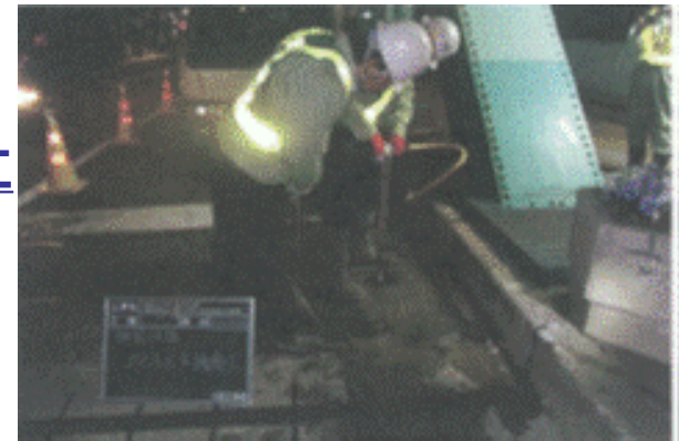
試掘による舗装の健全度調査
