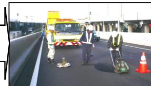
路面補修(パッチング処理)
