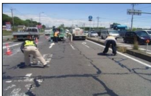
シーリング材注入
