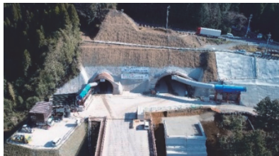
図-5 二重峠トンネル
