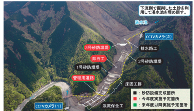
図-13 赤谷地区の砂防設備の整備状況（令和2年7月）
