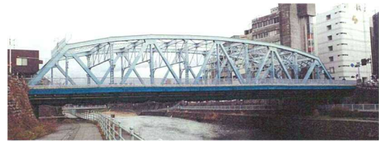
写真-3 犀川大橋
