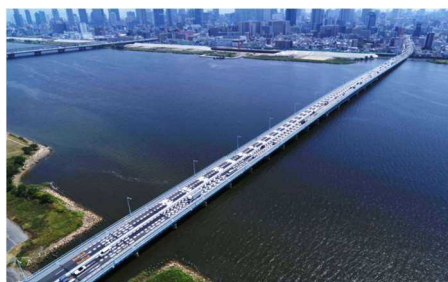
写真-1 淀川大橋
