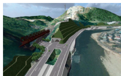
図-11 城山トンネル
