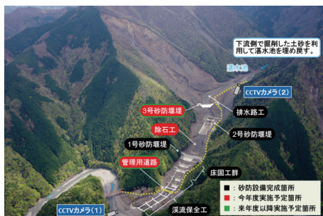
図-12 赤谷地区砂防設備
