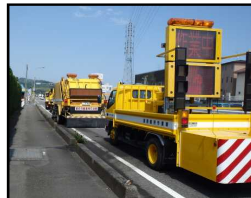
路面清掃作業状況
