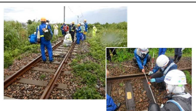
発注者、工事受注者との合同調査状況
