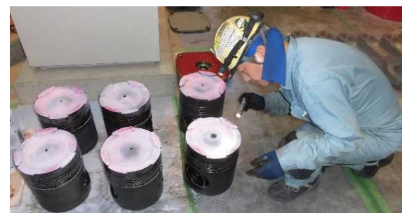
分解整備中 (シリンダーヘッド 浸透探傷検査※)
