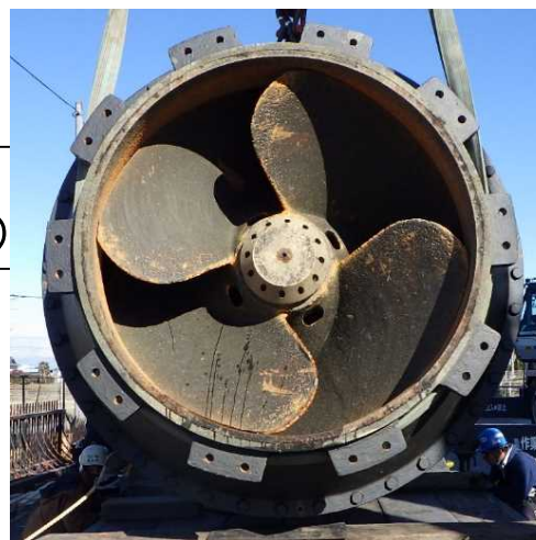
分解整備前 (ポンプ取外)
