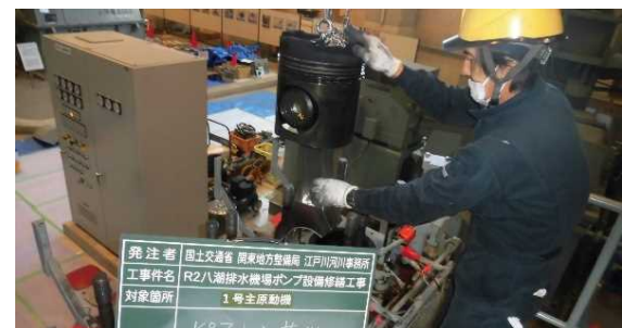
分解整備中 (ピストン取外)
