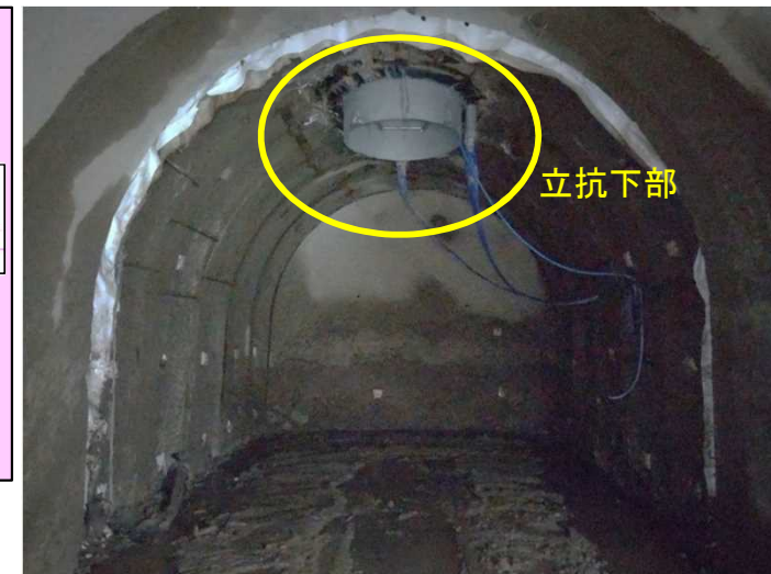
立坑下部(排水トンネル貫通部)
