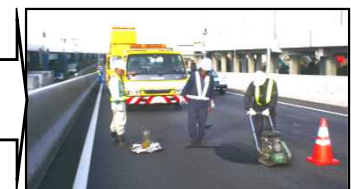
路面補修(パッチング処理)
