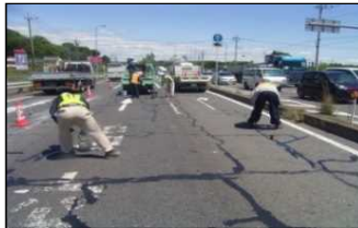
シール材注入
