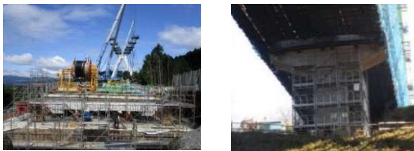
地震により被災した長大橋梁等の復旧事業
