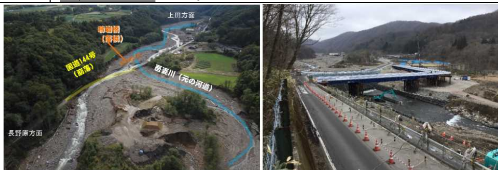
被災後 現地状況
