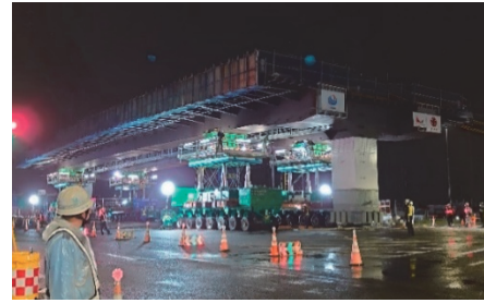
写真-2 多軸式特殊台車を用いた大型ブロック架設
