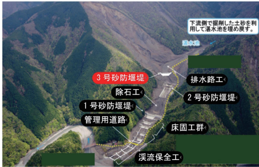
写真-3 赤谷3号砂防堰堤工事
