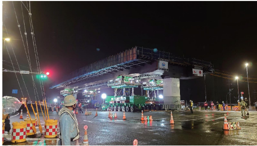
写真-2 大樋橋西高架橋工事
