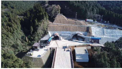
写真-1 二重峠トンネル工事
