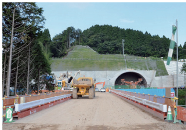
(a) 大津工区
