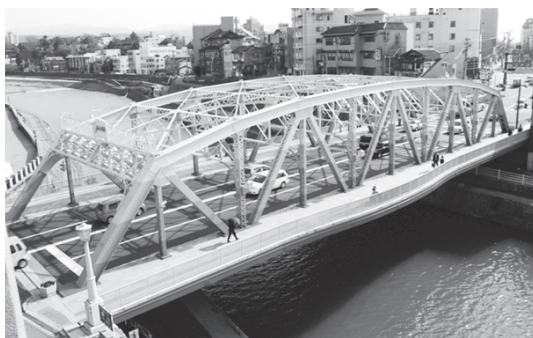
写真-3 犀川大橋
