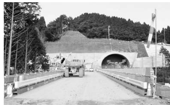
写真－2 二重峠トンネル
