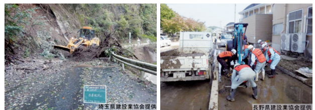
道路啓開 (埼玉県秩父市内)
