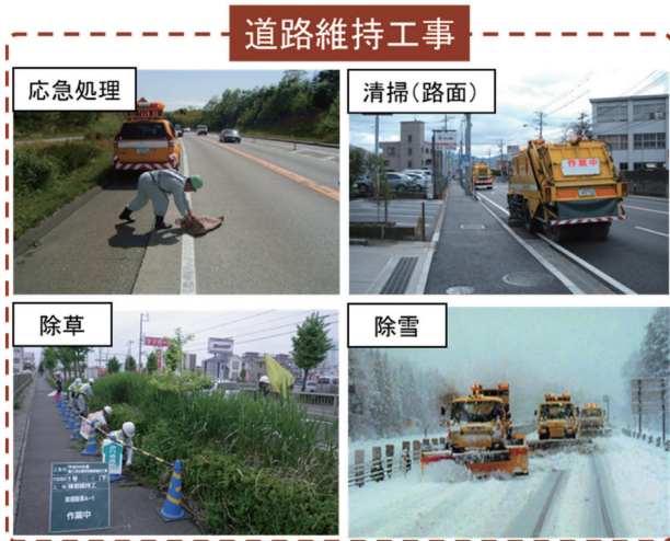
図-4 インフラの維持管理（維持工事）
