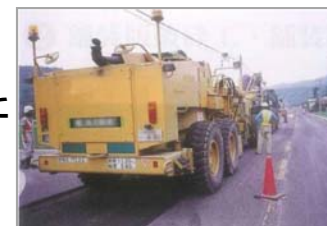
路面切削作業
