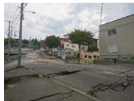
【宅地被害の状況】 (北海道札幌市清田区)
