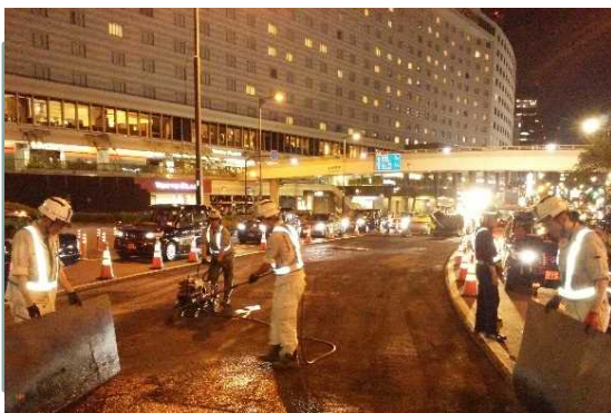
【交通量の多い箇所での施工(維持工事)】
