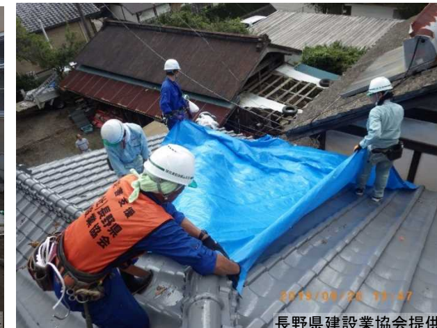
ブルーシートによる屋根瓦の補修 (千葉県内:令和元年台風15号) 13
