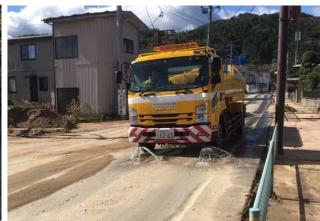
10月23日 宮城県丸森町における散水車による路面清掃【近畿地整・道路清掃班】
