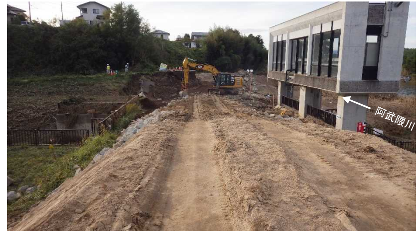
仮堤防盛土施工状況
