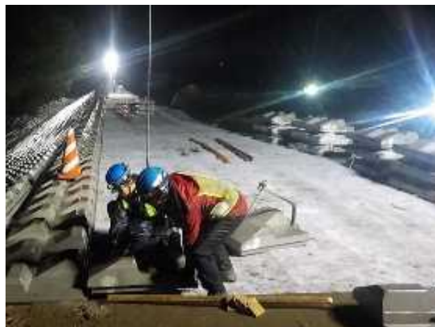
仮堤防の補強 (那珂川:茨城県内)
