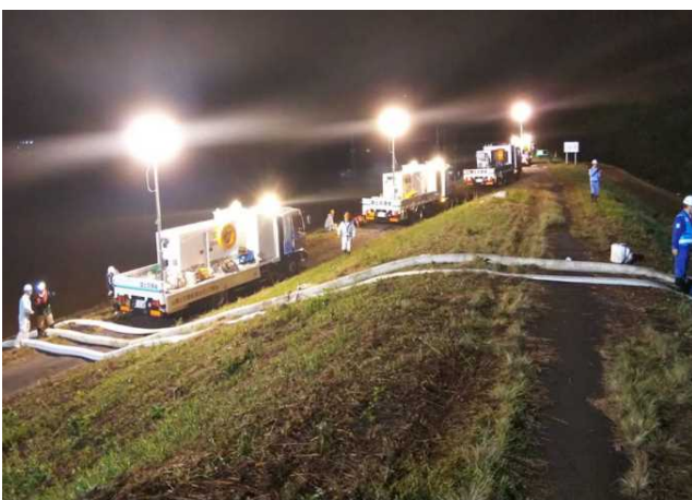
10月14日 荒川水系越辺川における排水ポンプ車による排水活動状況【九州地整】
