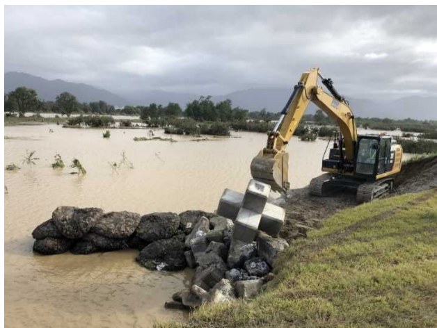
破堤部の小口止 (千曲川:長野県内)
