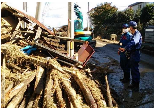
10月23日 宮城県大崎市の道路啓開状況の確認・指導【中国地整・高度技術指導班】
