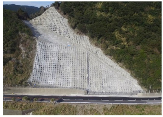
法面对策(道路)
