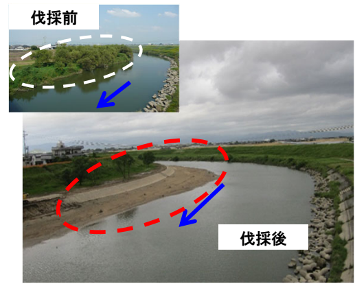
河道掘削・樹木伐採(河川)
