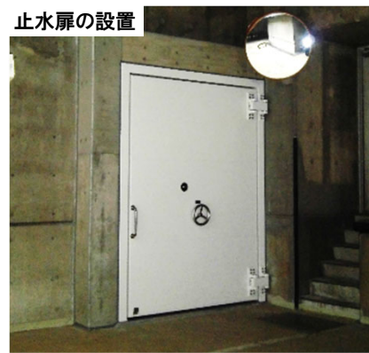
電源設備等の浸水対策(空港)
