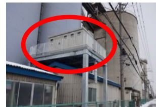
電気系設備の嵩上げ
