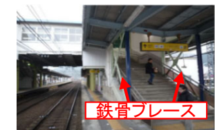
鉄骨ブレースによる駅の耐震補強
