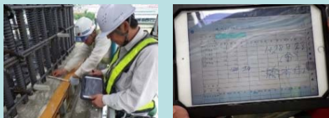
現地立会 出来形確認(ASP直接入力)
