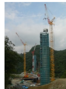
クレーンで吊り込み設置
