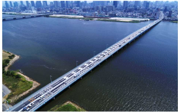
写真-3-1 淀川大橋
