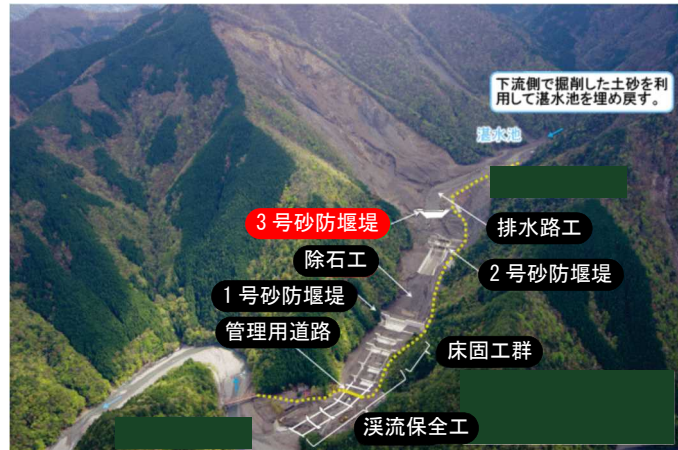
写真-3-4 赤谷 3号砂防堰堤工事
