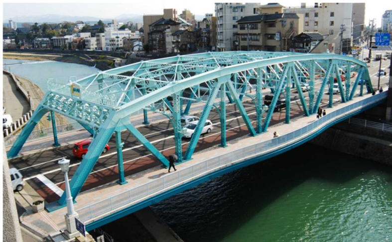
図 参 4-1 国道 157 号犀川大橋
