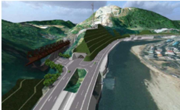
図-3-5 城山トンネル
