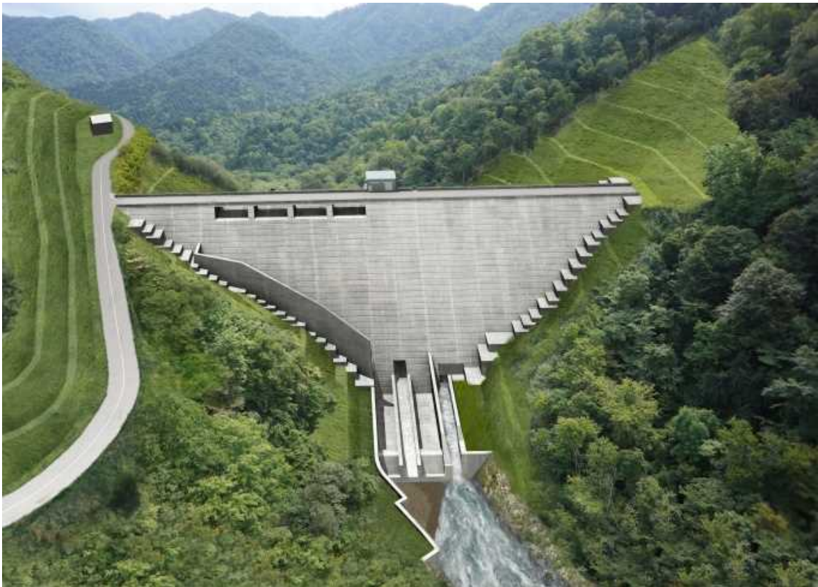
図 参 27-1 三笠ぽんべつダム堤体建設第1期工事
