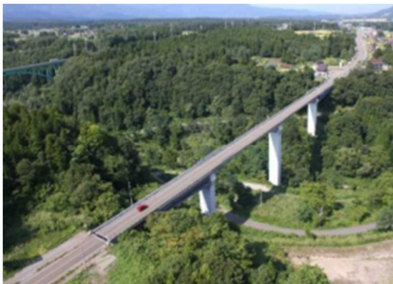
図 参 22-1 妙高大橋上部撤去工事
