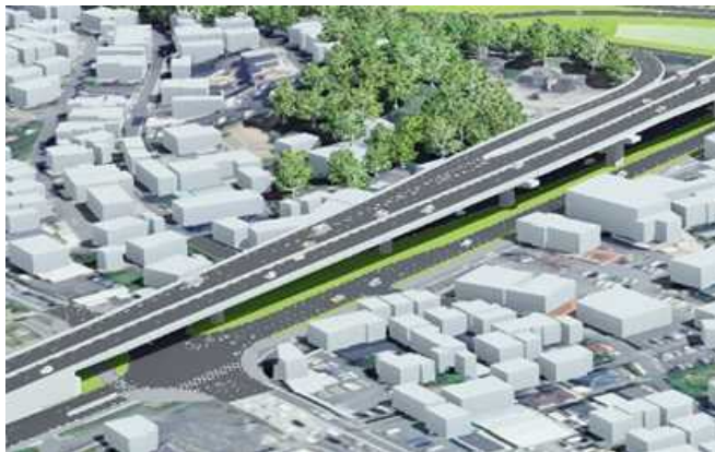
図-3-10 八坂高架橋
