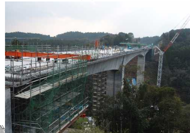
施工状況 (株)銭高組提供
