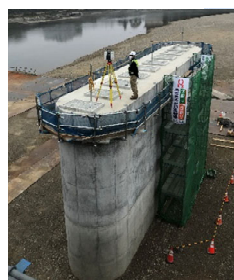
従来施工 (高所での測量)
