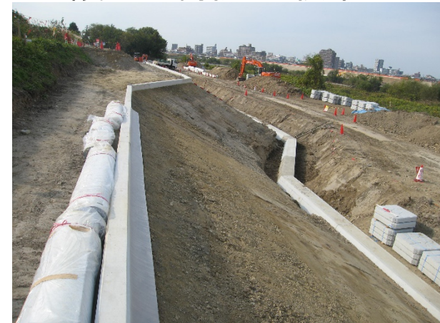
基礎工(護岸) (プレキャスト)
