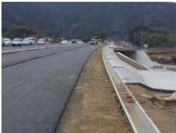
側溝工(U型側溝)
