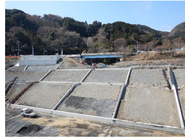
護岸付属物工(横帯工)
