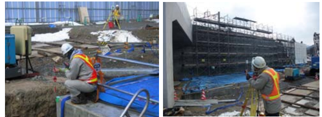
写真-2 TSによる計測点（擁壁工）
