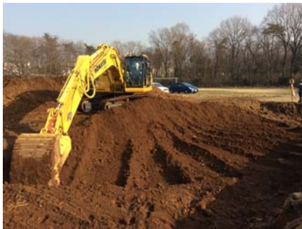
写真-2 試験 A の掘削状況
