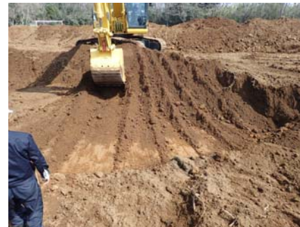
写真-4 試験 B の掘削状況
