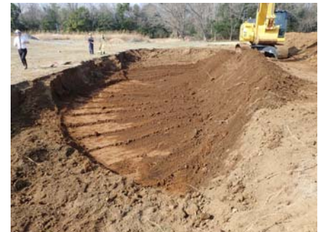
写真-6 試験 C の掘削状況
