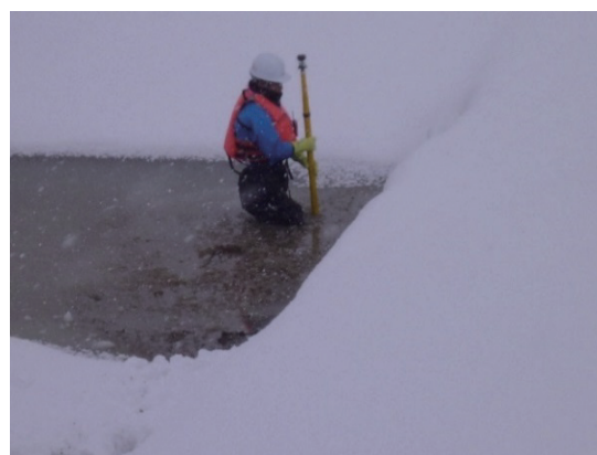
図-1 水没した河床の出来形計測の様子
