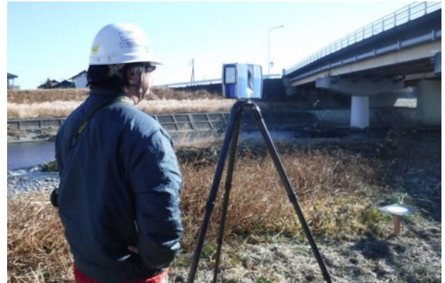
図-4 地上型レーザ計測の作業風景
