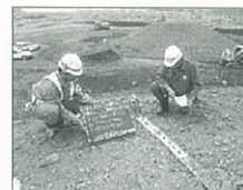
現状：巻き尺による出来形の計測
