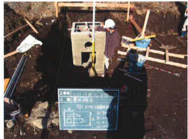
写真-1 現行の集水升の出来形管理
