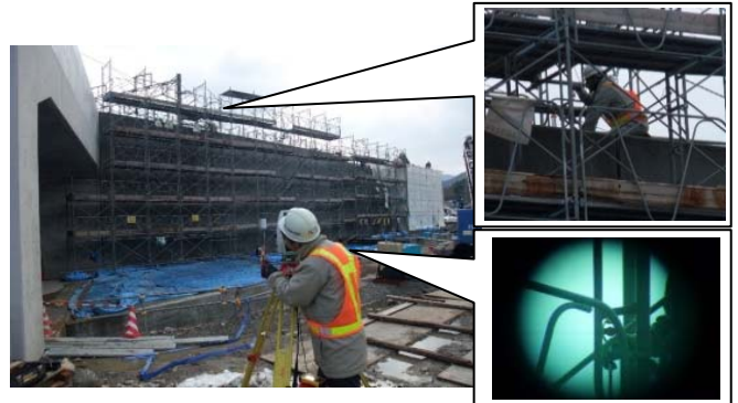
図 4 擁壁工の TS 出来形計測の様子
