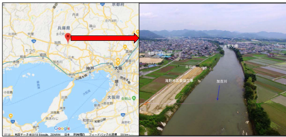
図 11 滝野地区築堤工事の位置
