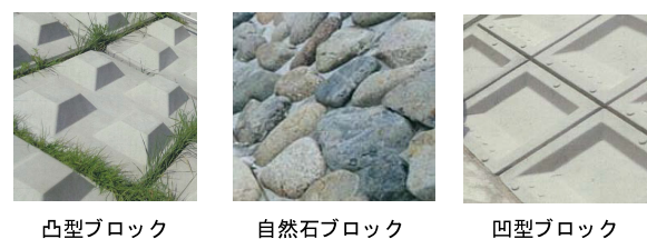
図 2 ブロック工で設置するブロックの例
