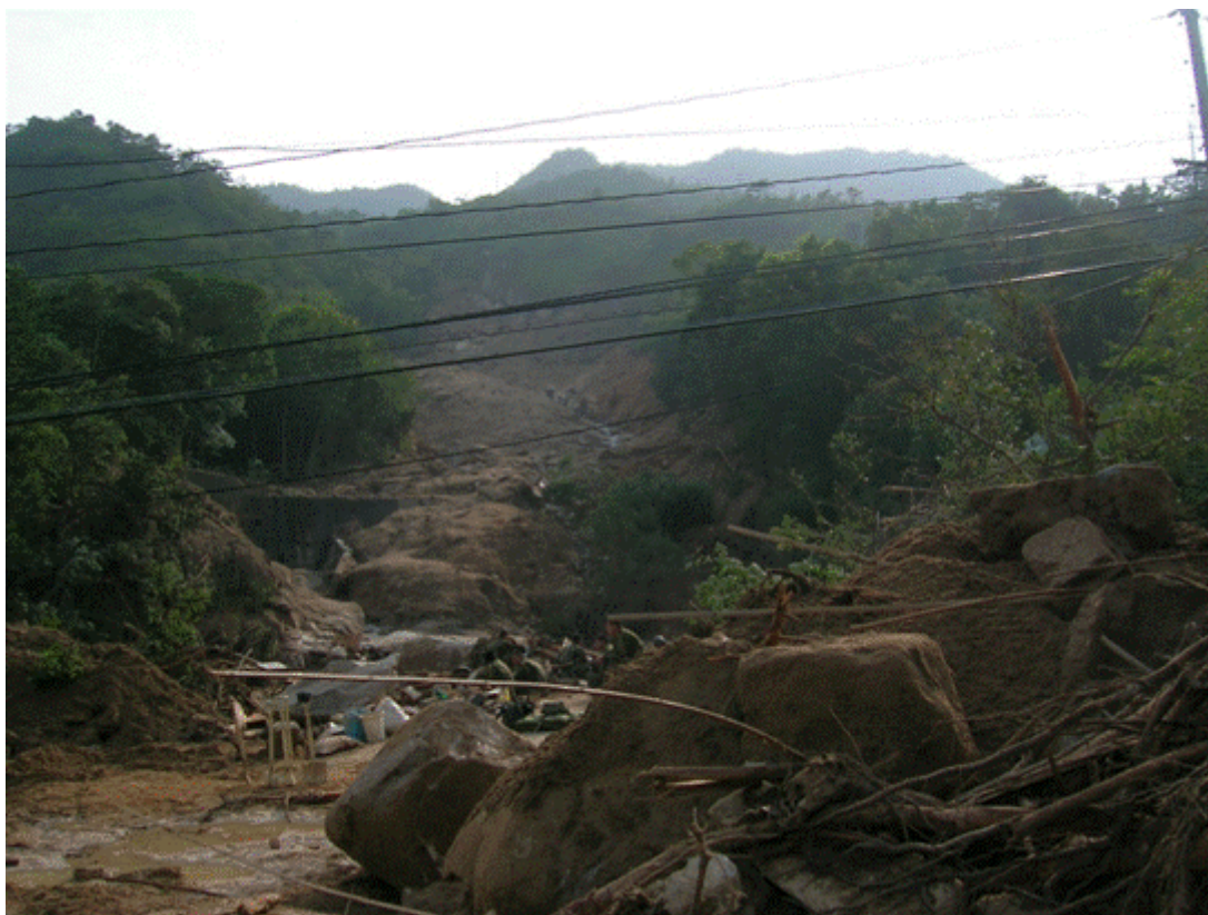
比較的深い斜面崩壊
