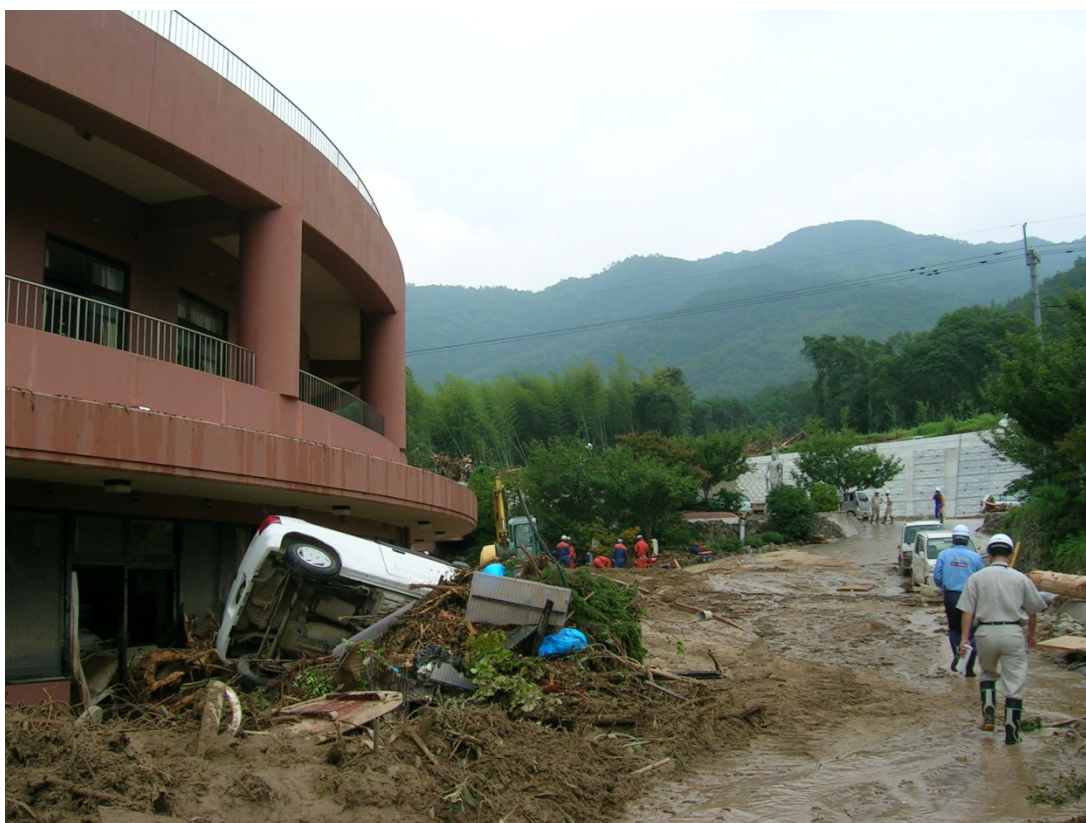
老人ホーム周辺の土砂堆積状況(土砂は細かい材料が大半)
