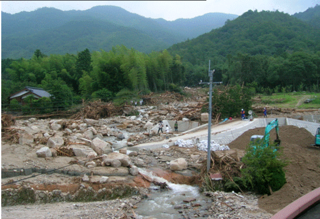
巨礫の堆積域の下流端(写真中央付近のコンクリートは農道) 老人ホーム屋上より撮影
