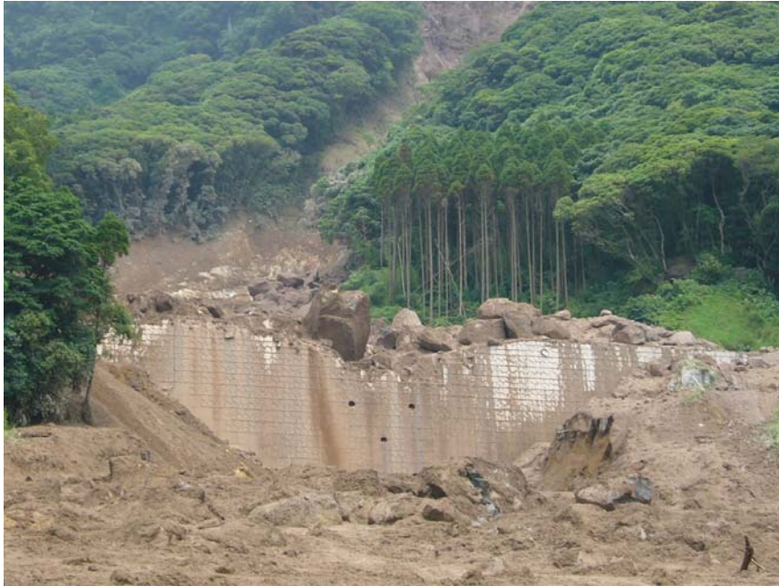
写真－3 2号砂防堰堤（平成22年7月7日午後撮影） 2号堰堤水通し部および袖部には2mを超える巨礫が多数堆積している。
