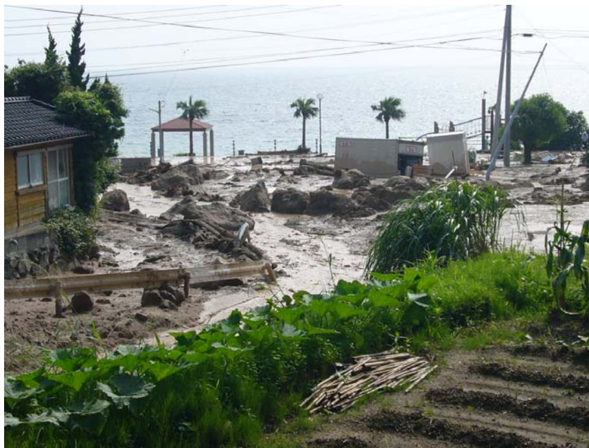
写真－6 船石川と国道269号が交差した地点を上流から望む （平成22年7月7日午後撮影）
