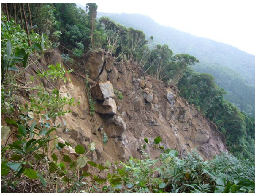
写真－2 崩壊地左岸（平成 22 年 7 月 7 日午後撮影）
