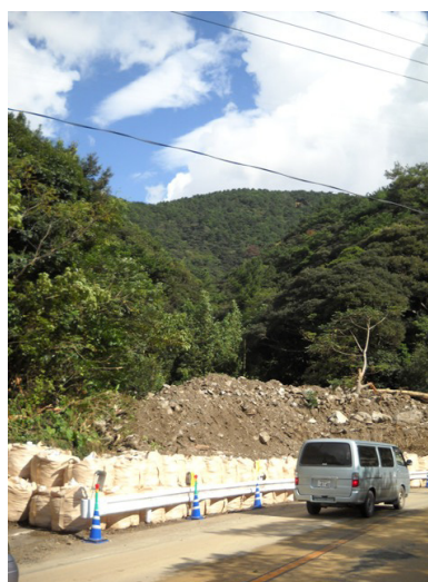
国道 58 号を埋塞した土砂、正面奥が河道
