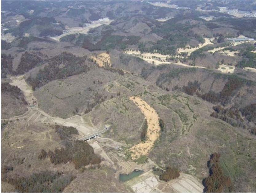
④新幹線トンネルの付近の斜面崩壊（写真奥側 福島県白河市中丸地区付近） トンネル付近の斜面に崩壊が見られた。
