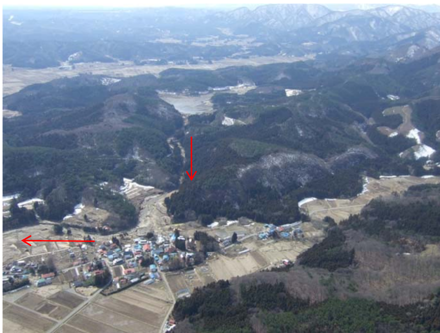
⑤福島県須賀川市藤沼貯水池からの湖水流出による下流集落への被害 (下流集落側から貯水池を撮影)
