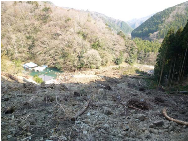
写真5 人家まで到達した土砂（崩壊中腹部のテラスから撮影）
