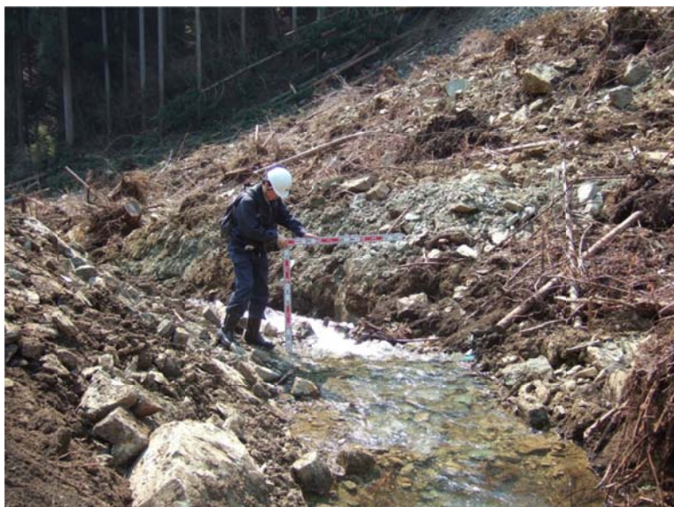
写真 1 3 開削された水路の断面（写真奥側下流）
