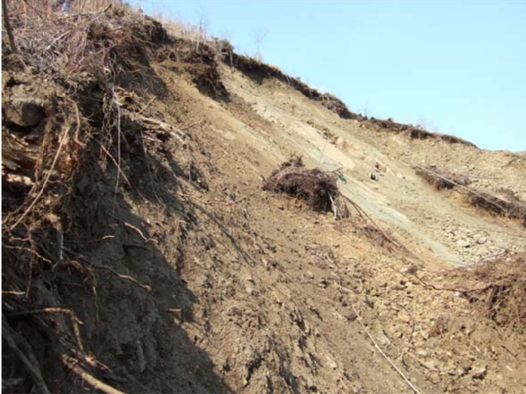
写真2 崩壊源頭部（中央部に露岩が見られる）
