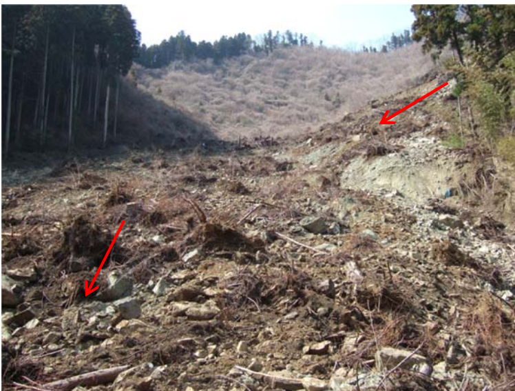
写真3 左側の谷地形と摺り付き部
