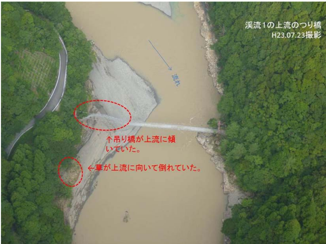
写真4 上流側吊橋の被災状況
