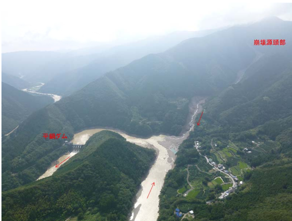
写真2 平鍋地区土石流全景
