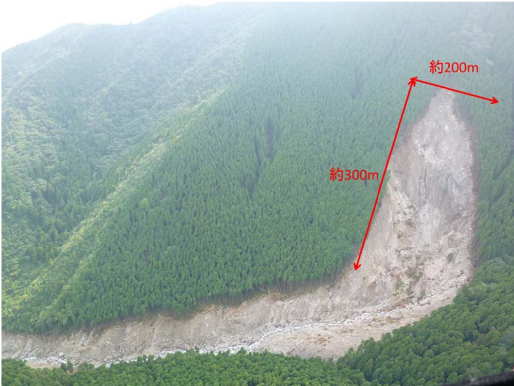
写真3 平鍋地区土石流の崩壊源頭部
