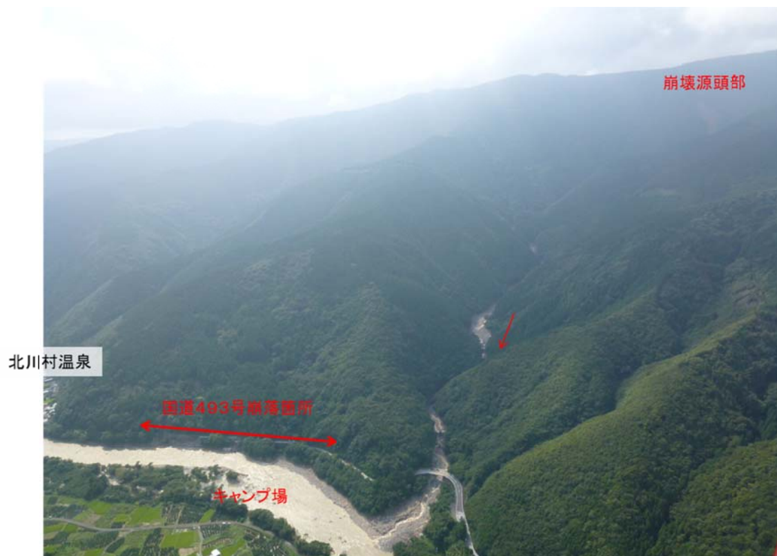
写真5 北川村温泉上流の土石流全景
