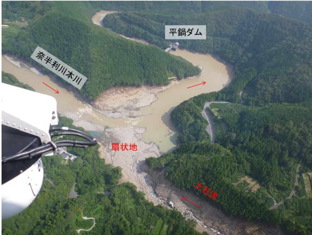
写真1 平鍋地区土石流発生溪流と奈半利川本川との合流部
