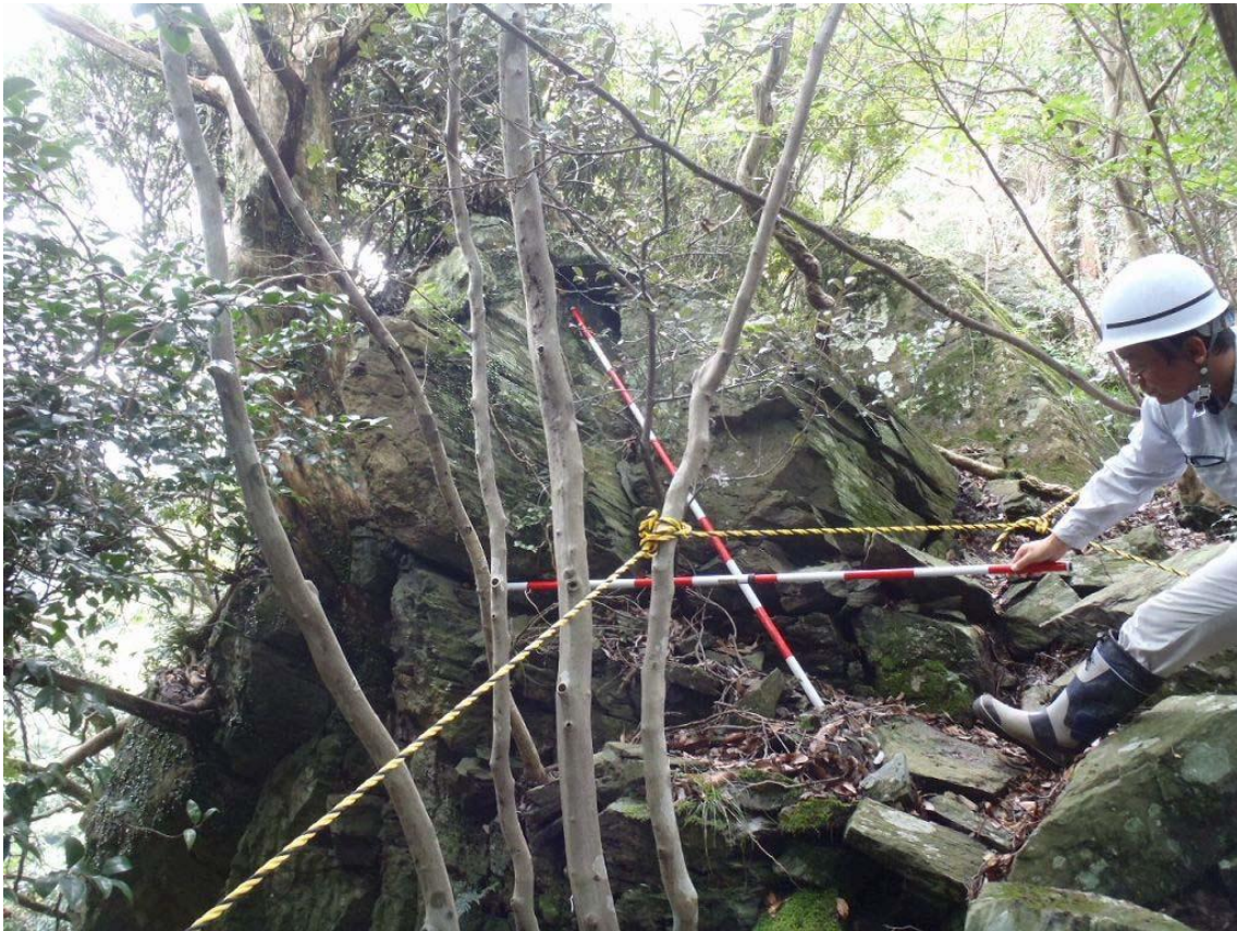
写真-5 崩壊地頭部の岩塊
