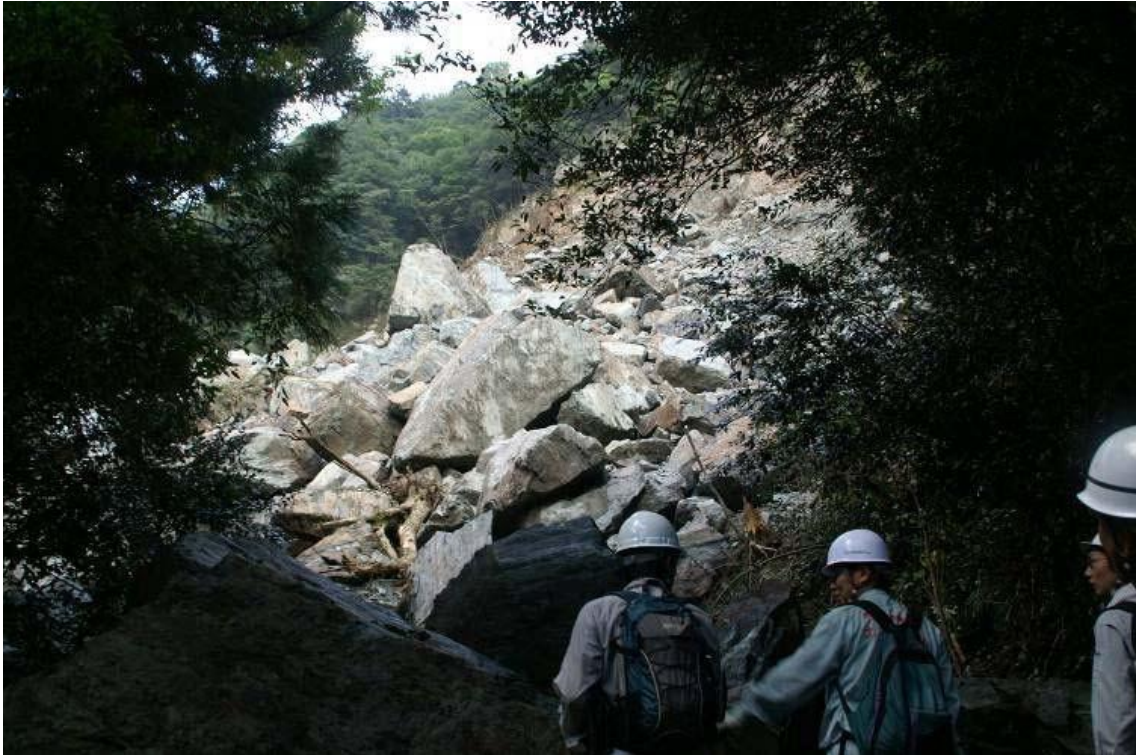
写真-7 崩壊地下流側の道路埋積部
