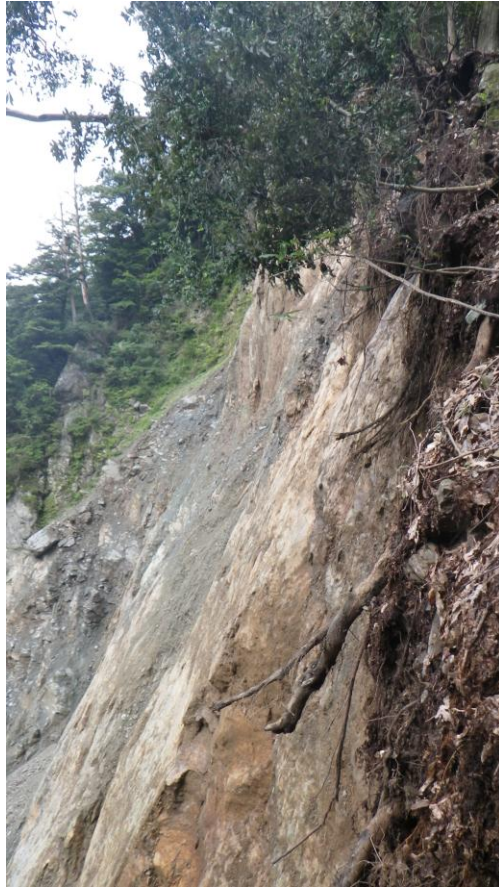
写真-3 崩壊地頭部の状況
