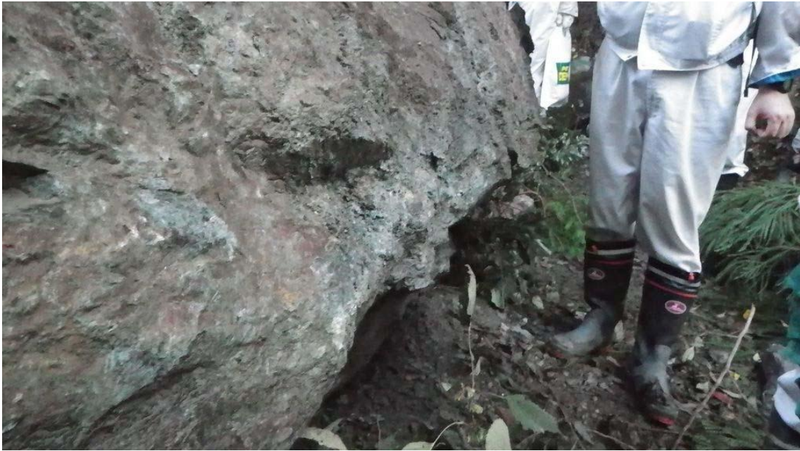
写真-9 巨大転石の脆弱化した部位（写真中央）
